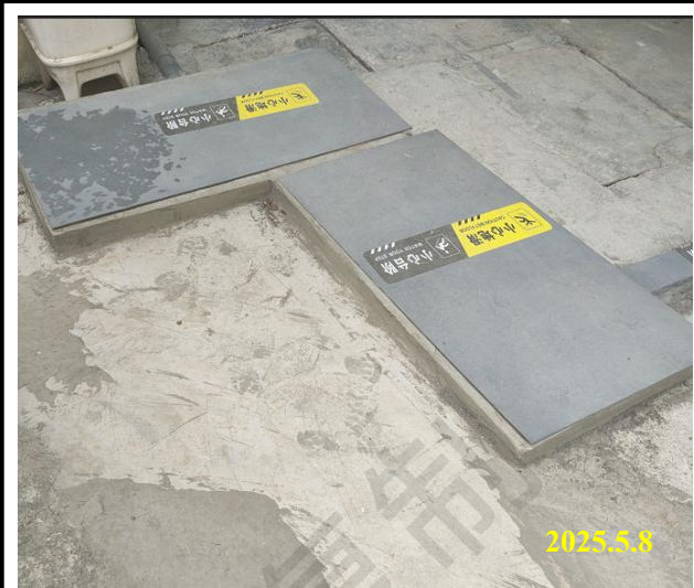
一体化污水处理设施
