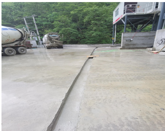
项目区雨水沟
