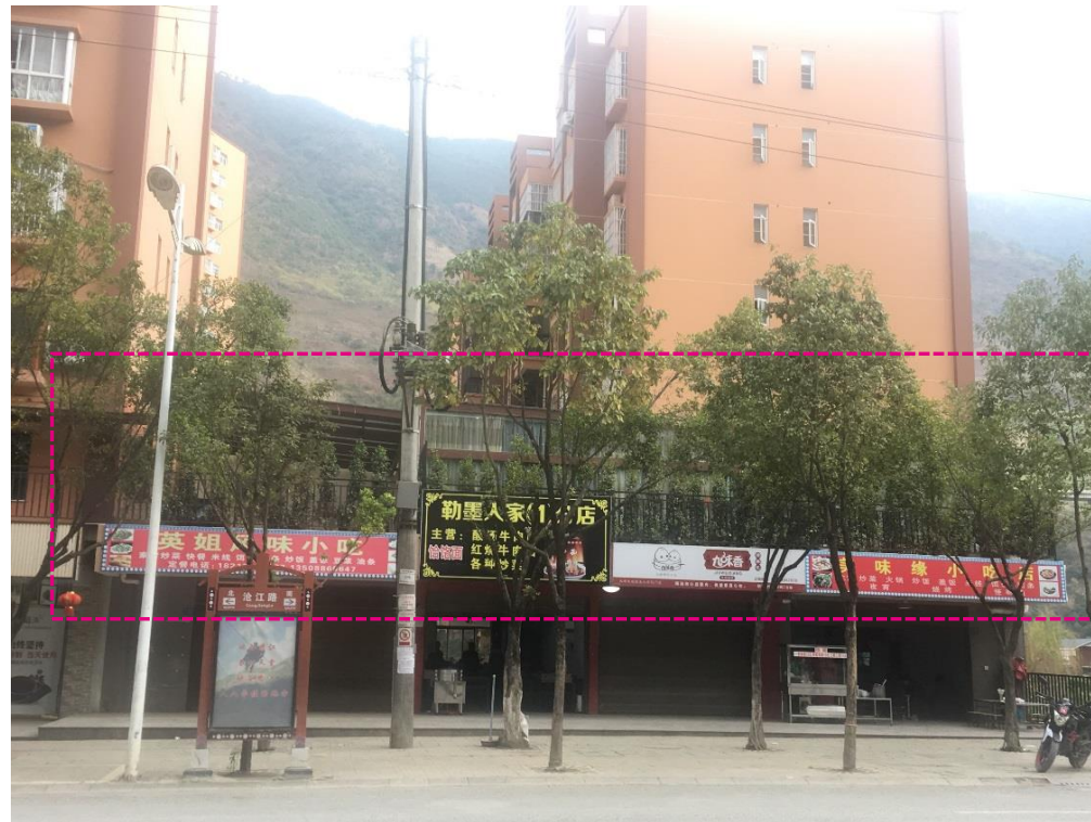
占用公共屋顶——居住小区沿街商业的屋顶
