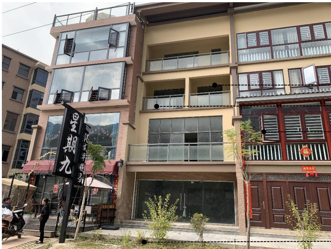
沿江现状照片
