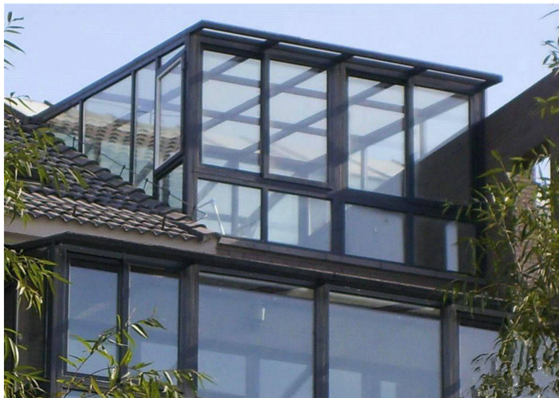
封闭式屋顶露台
