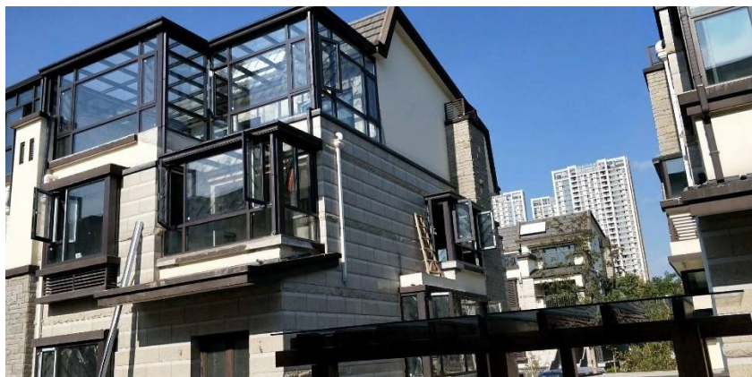
封闭式屋顶露台
