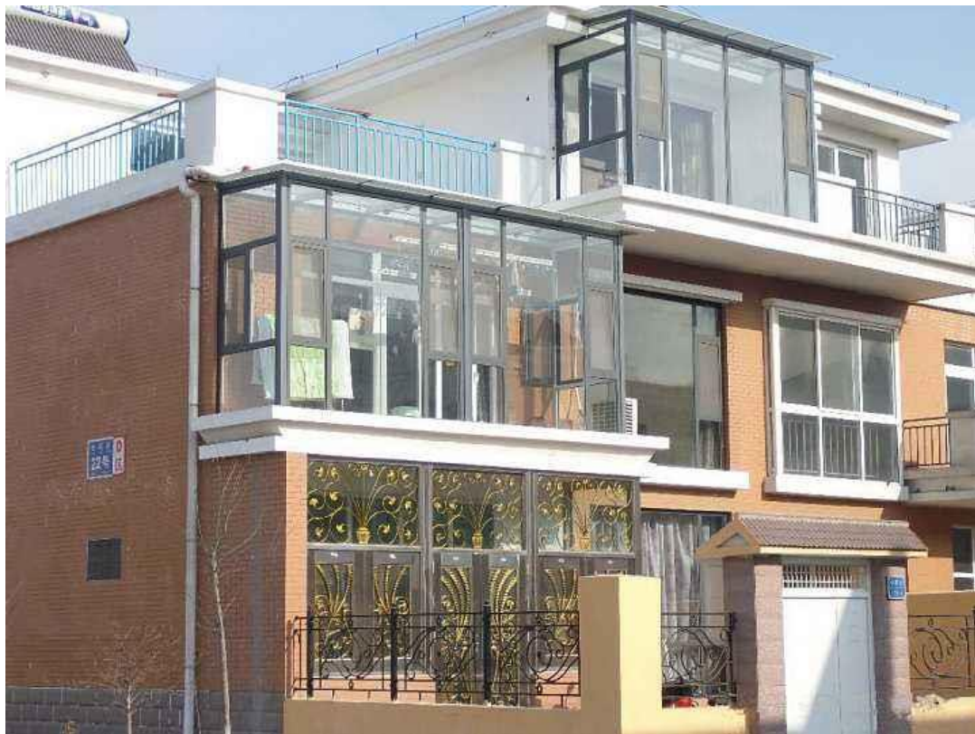
简约现代封闭式阳台：高度和立面不突破主体建筑的高度和立面，整体形态错落有致，材质以钢材和玻璃为主。
