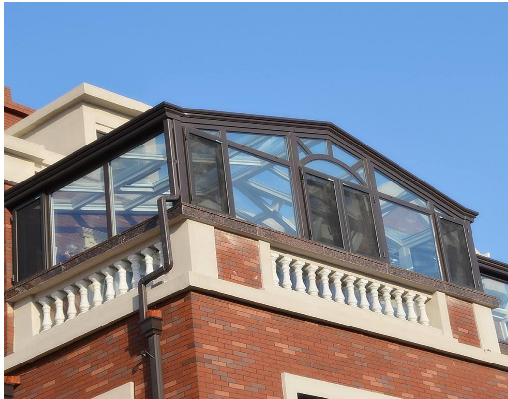
与建筑风格相协调的封闭式阳台：整体形态和轮廓与建筑风格统一，高度控制适宜，材质以钢材和玻璃为主。
