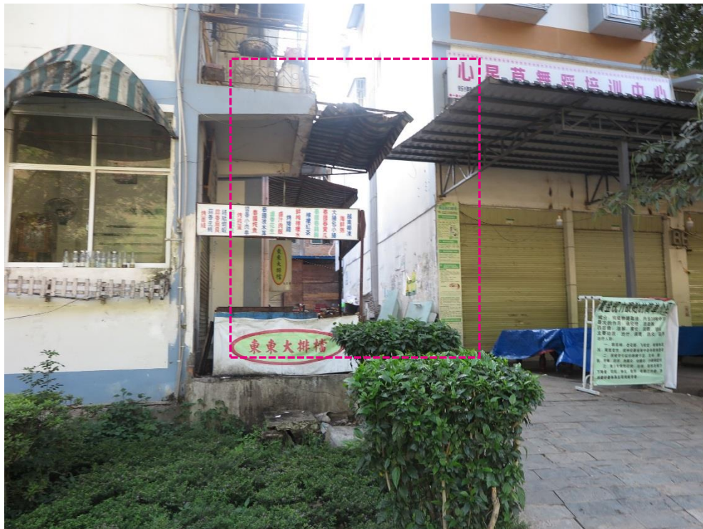
占用消防通道——自建房
